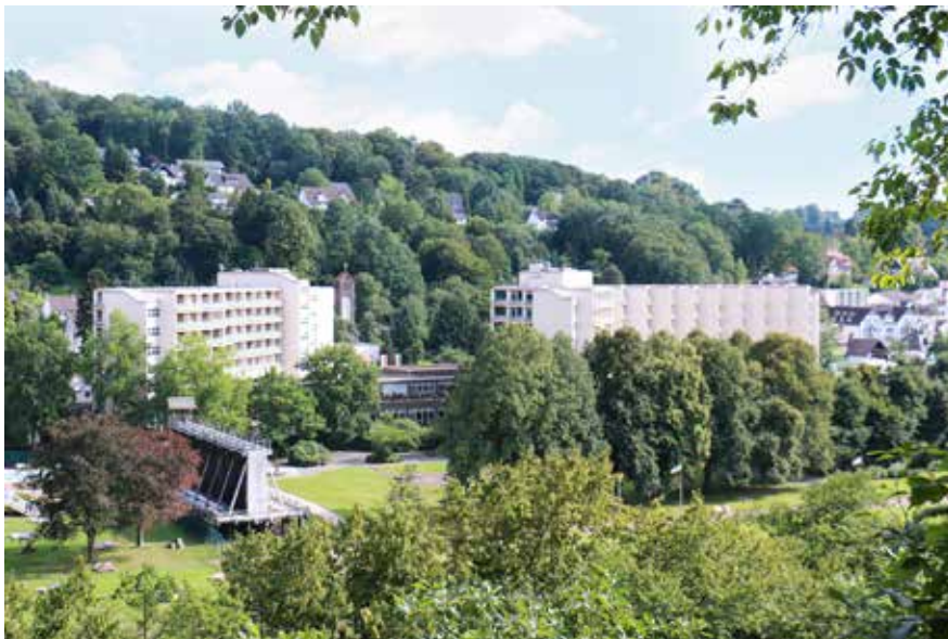
Abbildung 1: In der idyllisch gelegenen Rehaklinik Carolinum im Heilbad Bad Karlshafen wurde das Heizsystem mit zukunftssicherer und effizienter Buderus Systemtechnik modernisiert.
