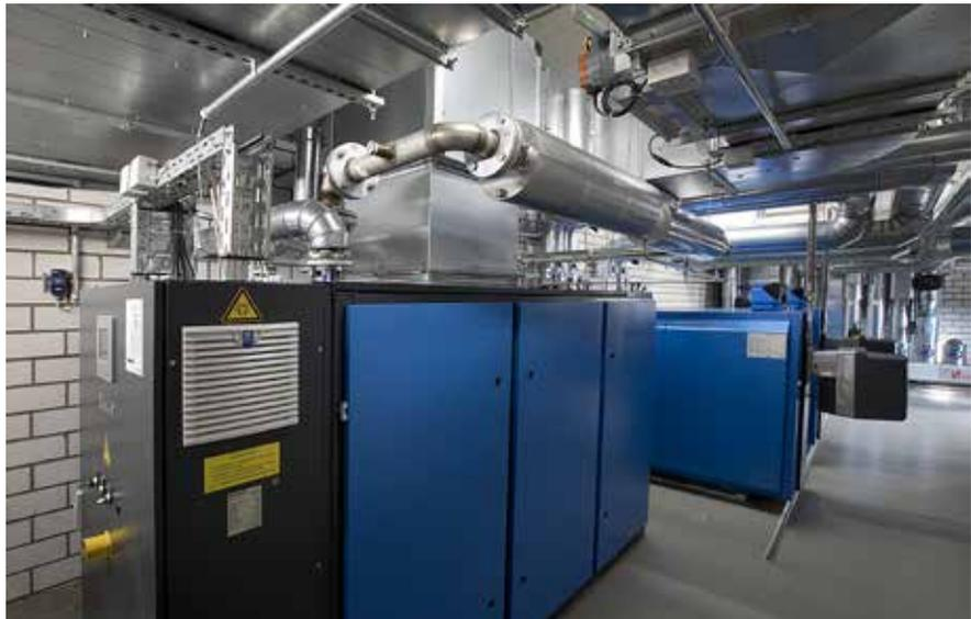
Das Buderus BHKW Modul Loganova EN50 hat 50 kW elektrische und 79 kW thermische Leistung.
